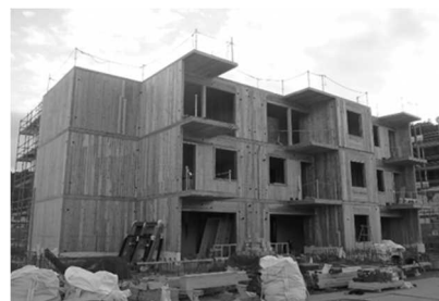
福島県いわき市・57戸(共同住宅)
