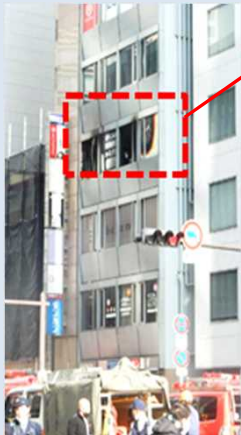
【火災建築物 外観】
