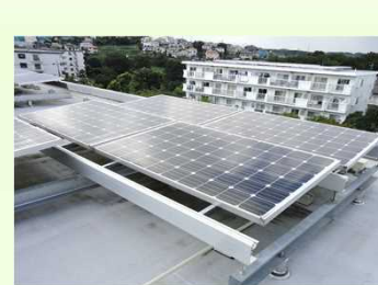
太陽光発電関連設備の設置
