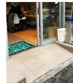
スロープの設置
