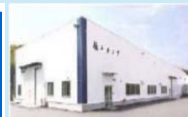
被災した工場・施設等の復旧支援
