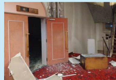
【被災したホテル館内】
