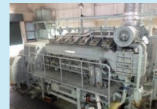
例：自家発電機の整備
