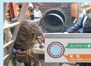
例：管路の耐震補強
