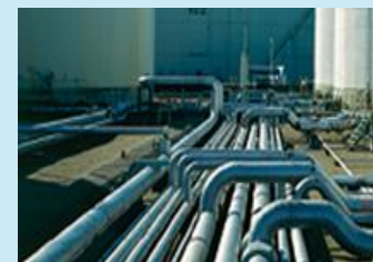
パイプライン
